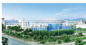
Завод в г.Жангжоу
