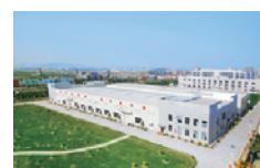
Завод в г. Джяомэй
